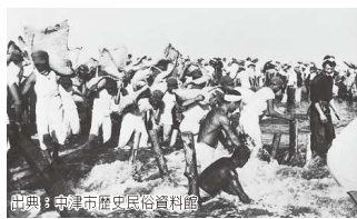
出典：中津市歴史民俗資料館 大水の復旧作業(昭和19年)、台風で決壊した個所に、砂を詰めた取(カマス)を運ぶ市民たち。
